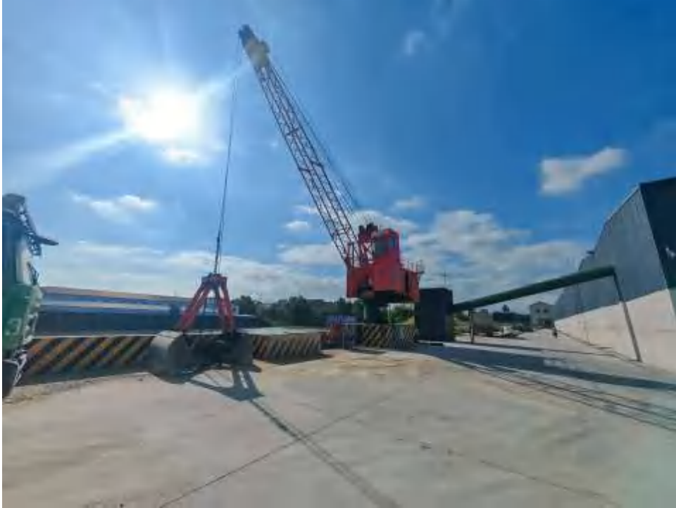
图3-1南码头现场图
