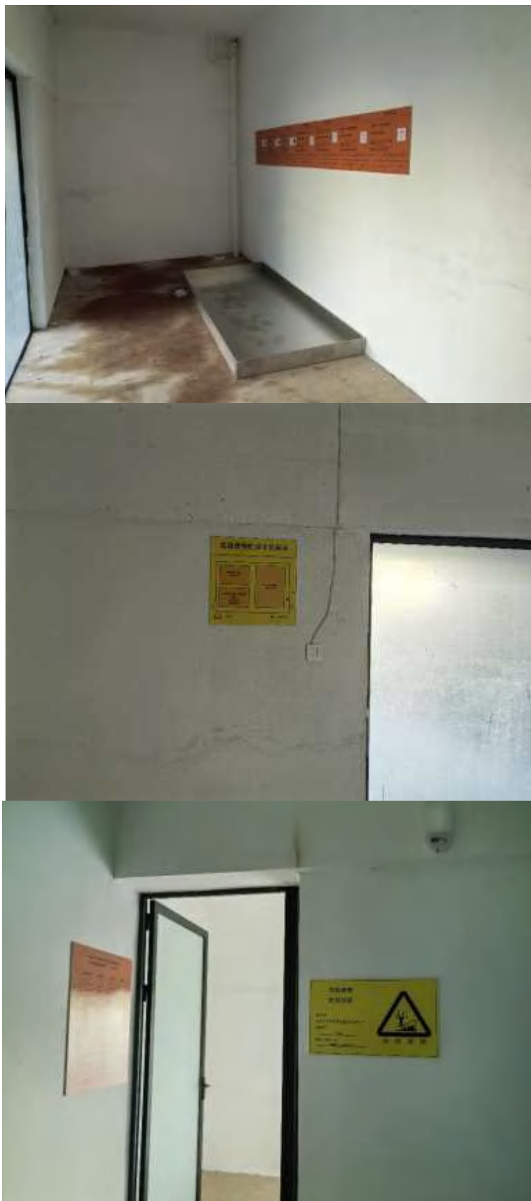
图 4-5 危险废物仓库
