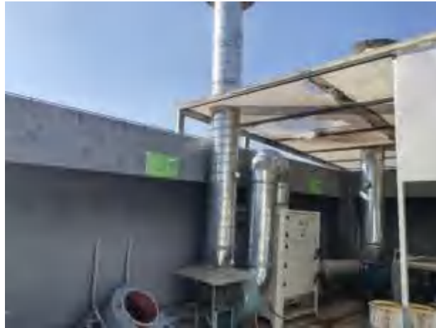
图 4-3 激光切割废气处理设施图片
