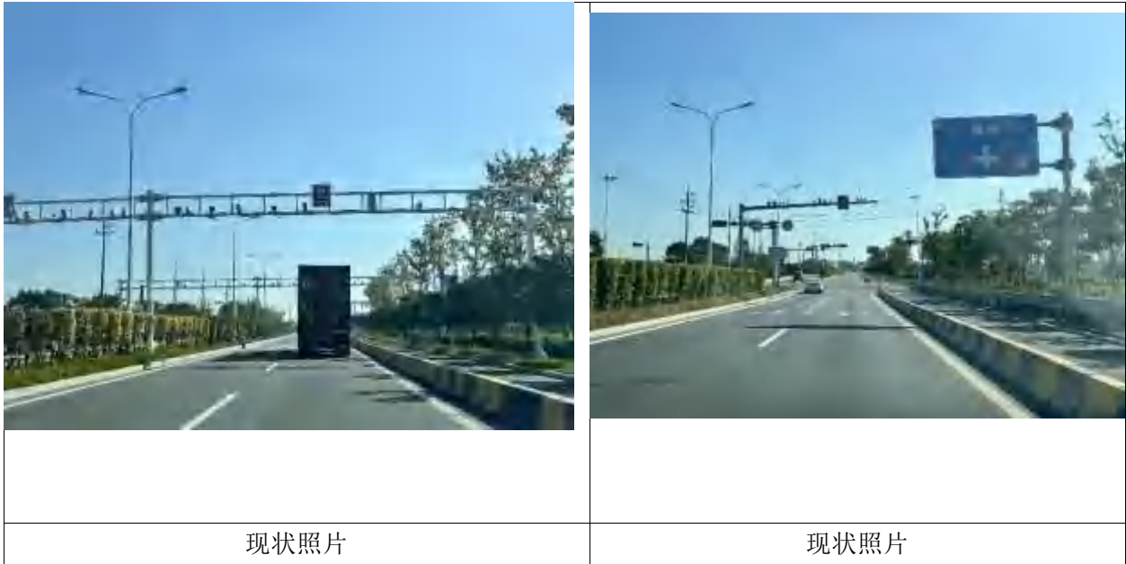
图5.2-1施工场地恢复情况
