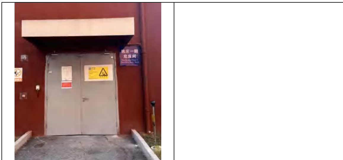
图 4-5 危险废物暂存间照片
