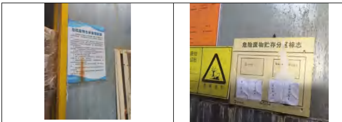
图 4-5 危险废物暂存间照片
