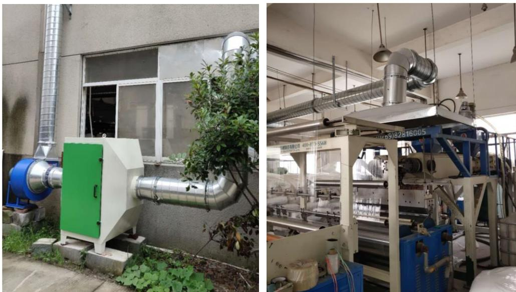
图 4-2 本项目有机废气处理设施图
